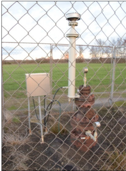
Ausbläser, mit Gaszähler im Kasten
